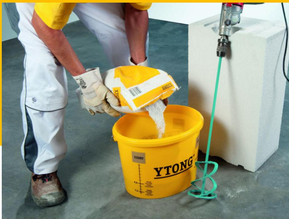
Le mortier-colle YTONG PREOCOL garantit une pose à joint mince des blocs. Il se présente sous forme de poudre, de couleur blanc cassé. En ajoutant de l'eau selon un dosage bien précis, on obtient une colle fluide.
