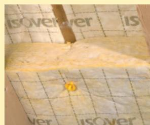
Embrochage de la membrane sur la **suspente Intégra 2** et clipsage de la clé.
