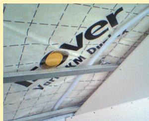
Clipsage de la fourrure métallique sur la clé générant un vide technique permettant le passage des gaines électriques.
