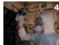
Pulvérisation du produit de traitement de bois D'XYL sur l'intégralité de la charpente
