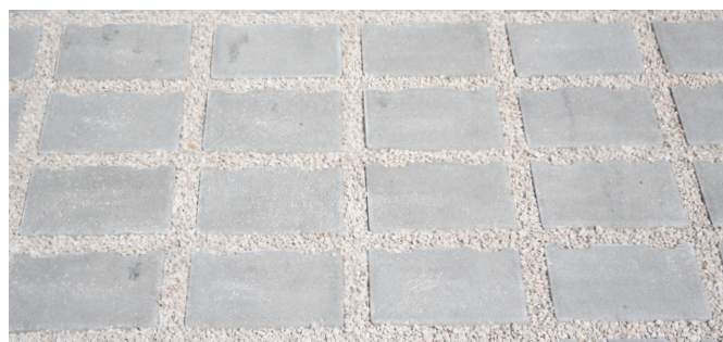
Pose joints alignés = exclusivement PIÉTONS
