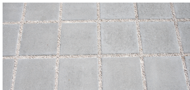
Pose joints alignés = exclusivement PIÉTONS
